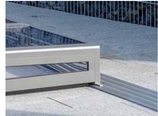
b Einseitige Führungsschiene: bei 4 Segmenten 23,2 cm breit, bei 5 Segmenten 29,1 cm breit.
